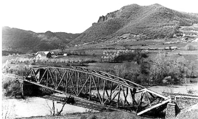
Слика 7. Срушен мост Туснић. 45
