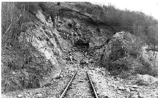
Слика 6. Зарушени улазни портал тунела Шарпељ. 44
